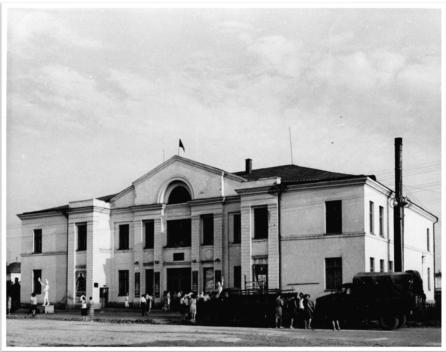
Здание городского Дома культуры (ул. К. Маркса, 169). 1967 г. Фотодокументы (города). Опись 1п. № 21
